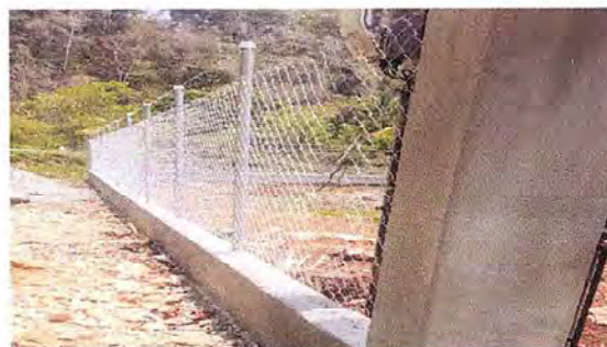
Foto 2: AQUÍ YA ESTÁ FINALIZADO EL PROYECTO YA SE REPELLO, LA COLOCACION DE TUBOS Y LA MALLA EN LA PARTE SUR.
