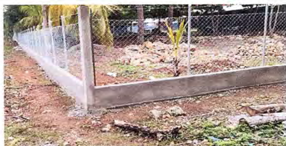
Foto 5: SE OBSERVA LAS DOS HILADAS DE BLOCK, LOS TUBOS, LA MALLA, LOS TAPONES Y EL ALMABRE ESPIGADO.
