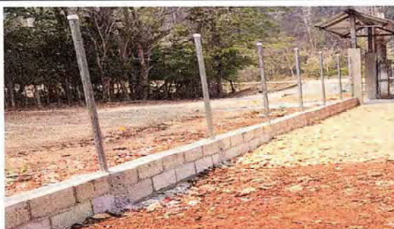
Foto 1: SE OBSERVA LAS DOS HILADAS DE BLOCK, LA COLOCACION DE LOS TUBOS.
