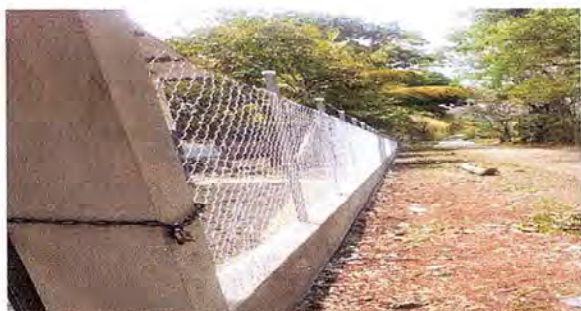
Foto 3: SE OBSERVA UNA PARTE DEL LADO ESTE YA ESTÁ FINALIZADO.
